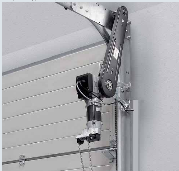
Стандартное положение для монтажа – горизонтально. На рис. изображено устройство с поставляемой по дополнительному заказу цепной ручной аварийной деблокировкой.
